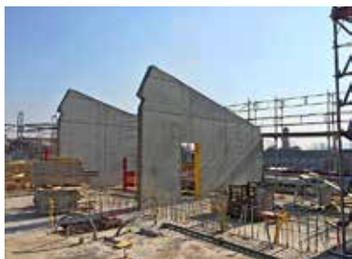
Abgeschrägte Wände im ersten Stock.
