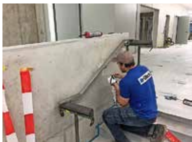
Montage des Handlaufes für die Treppe.
