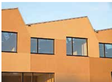
Unverwechselbar: das Sheddach.
