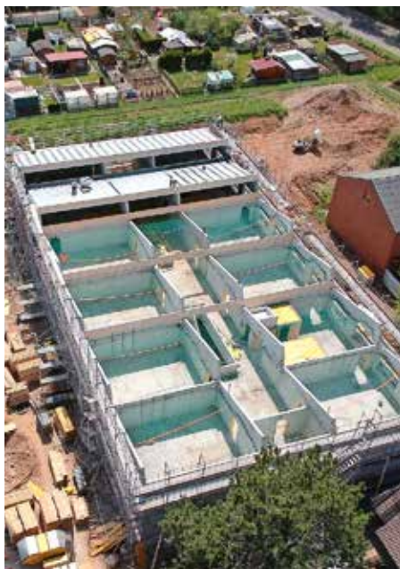
Blick auf die Unterrichtsräume im Rohbau.
