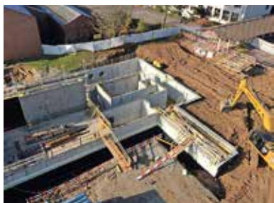
Das Untergeschoss nimmt Gestalt an.
