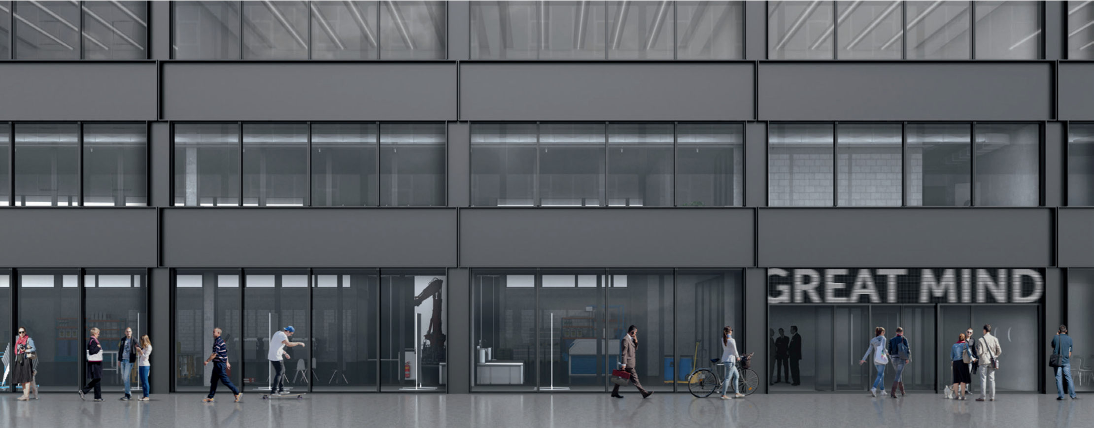
Der Neubau von SIPBB ist Minergie-P zertifiziert
