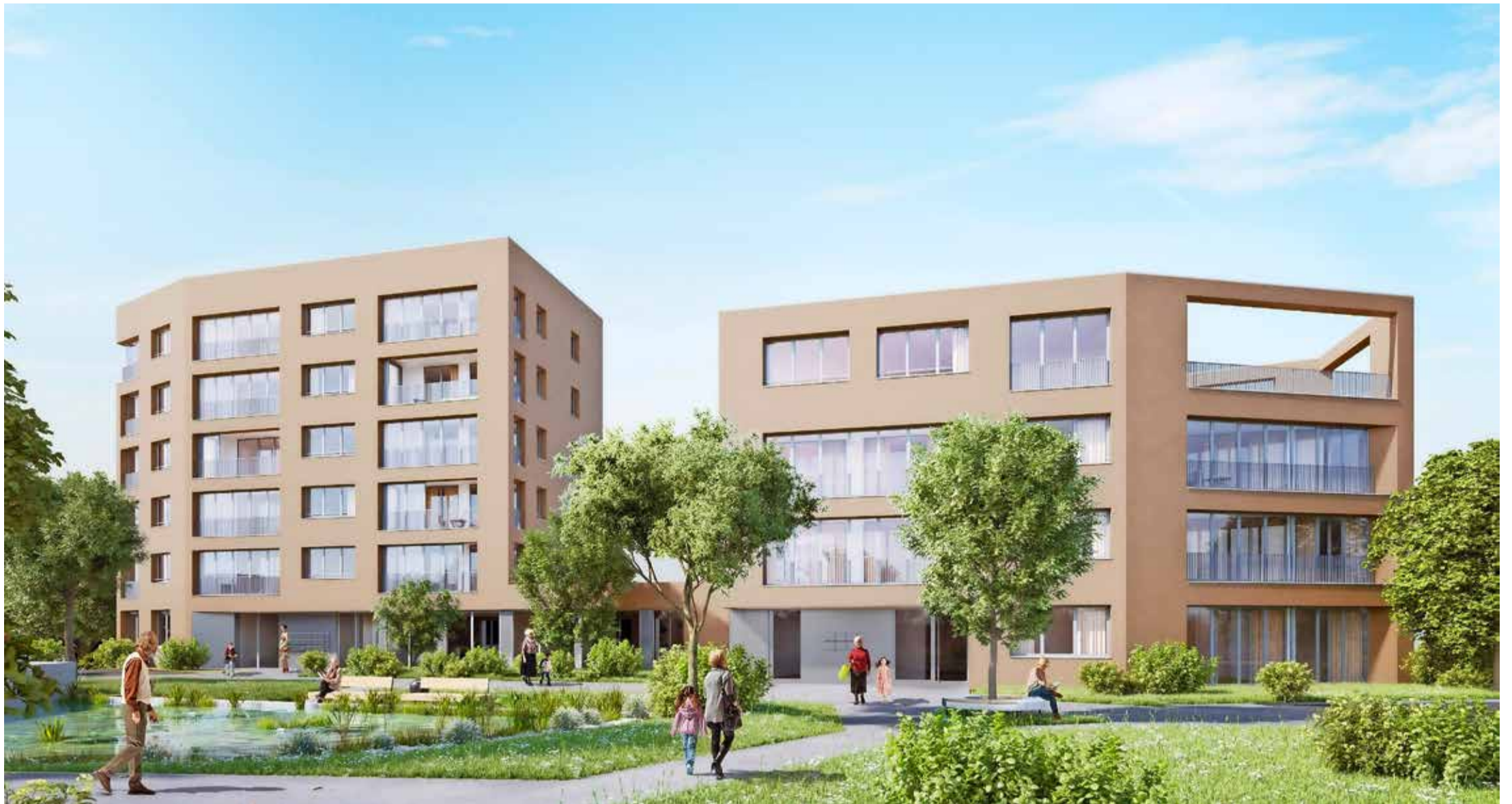
Nach dem Spatenstich im Februar 2017 entstanden auf dem Areal des Kompetenzzentrums Schönbühl die Häuser Ahorn (links) und Linde. Im März können die 22 Mietwohnungen in den Häusern bezogen werden.
